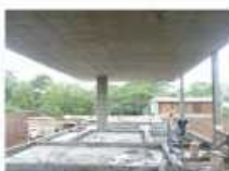
Postensado de H 2 A 2
