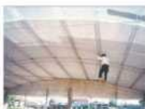
Aislación térmica y acústica
